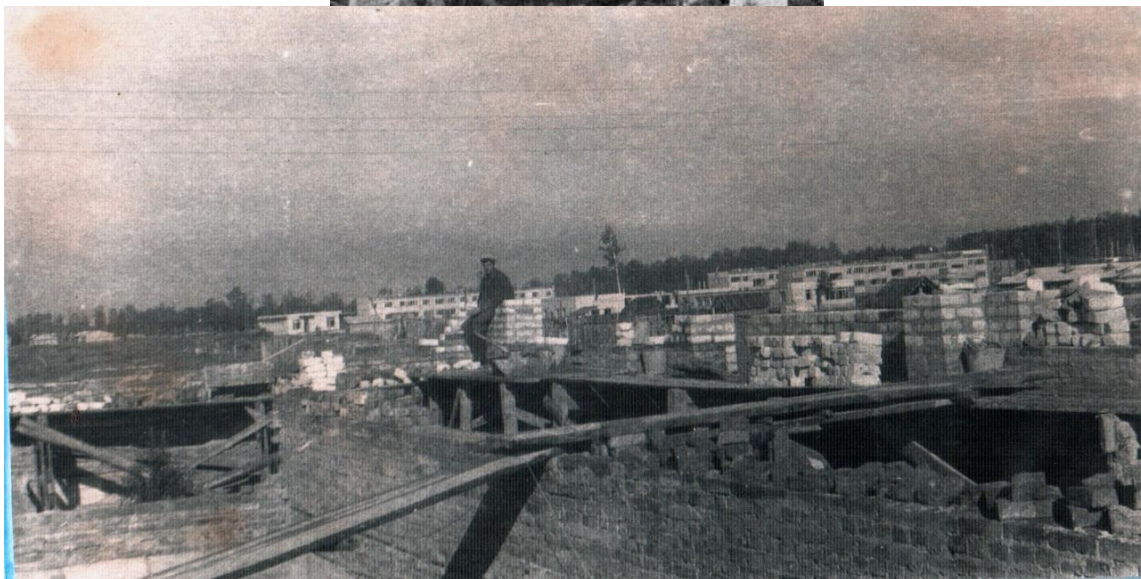
1970- Гриша строит электроподстанцию. Станция Картымская
