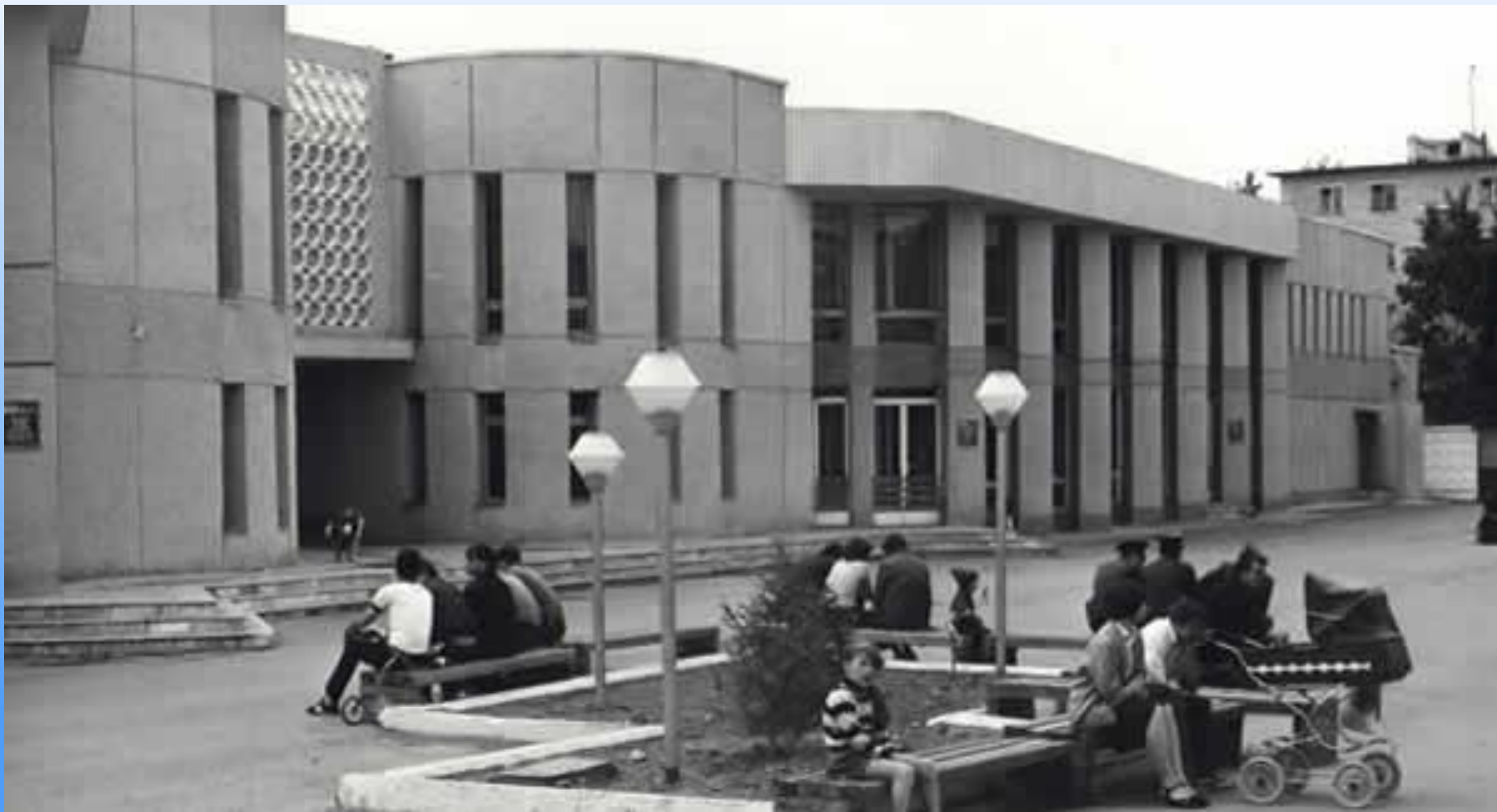
ТОРГОВЫЙ ЦЕНТР ОКТЯБРЬ
